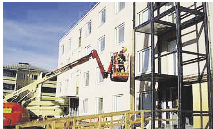
Ulkopuolisen hissikuilun asennusta KOY Heinolan Kisakulmassa
